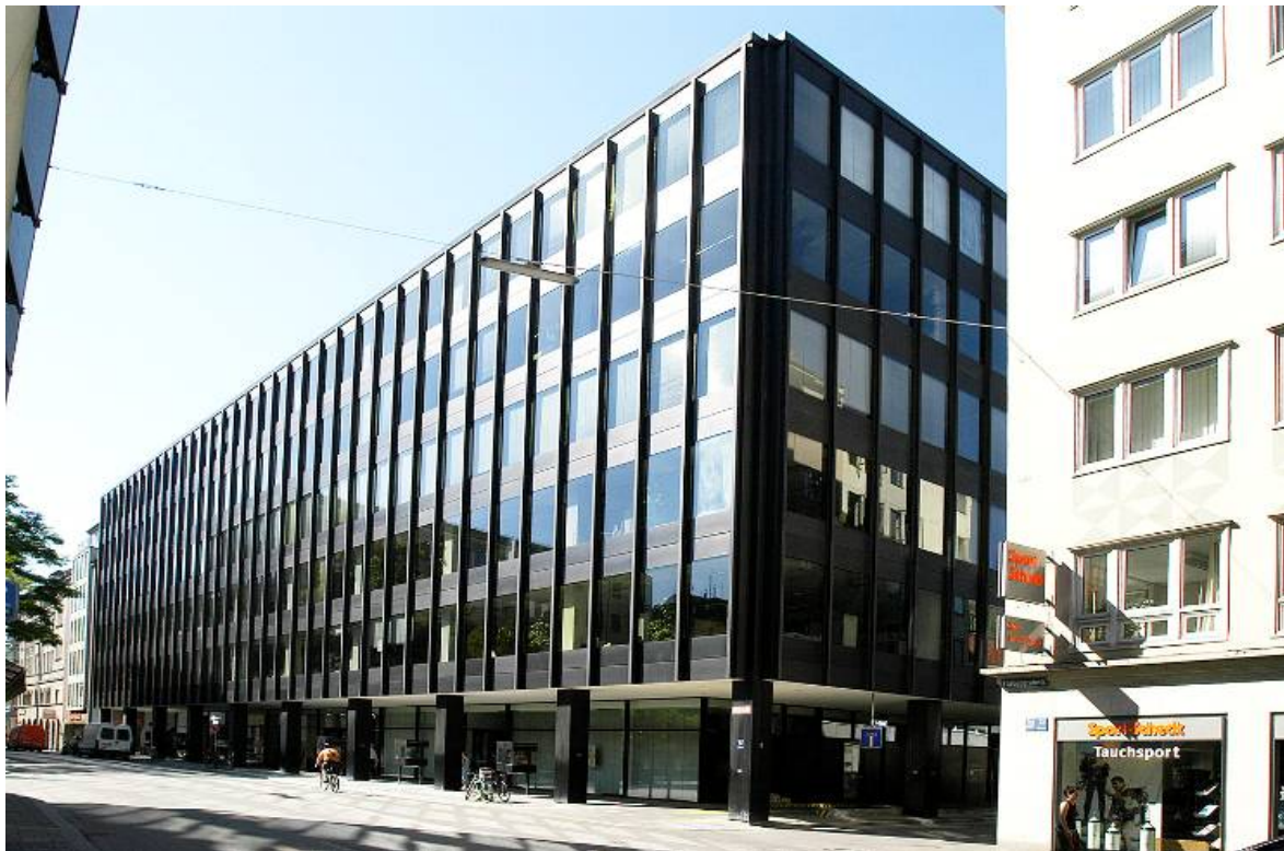
Ansicht Färbergraben, von Nordwesten
